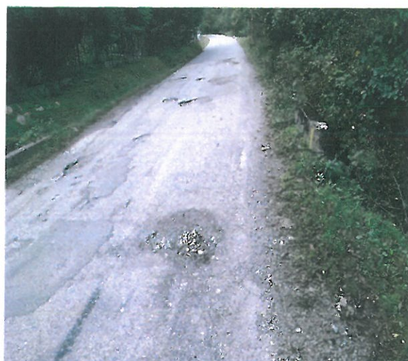
Degradări ale sistemului rutier sub formă de gropi, faianțări, tasări, pe DJ 671
