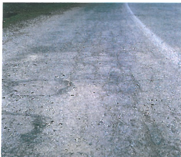
Degradări ale sistemului rutier sub formă de gropi, faianțări, tasări, pe DJ 671
