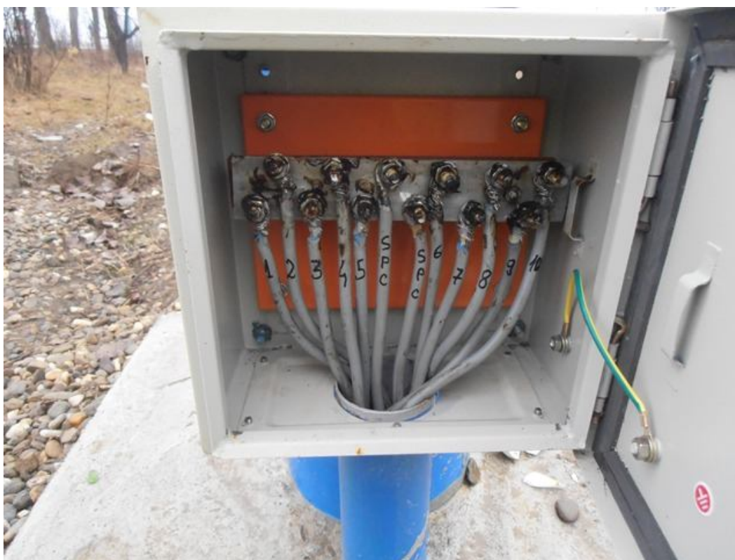
POZA 3 – Conectarea cablurilor de la fiecare anod in parte si de la SPC.
